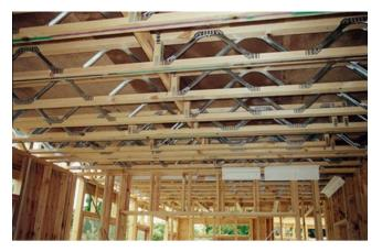
Fig. 13. Metal web joists (Mitek Posi-Joists).
